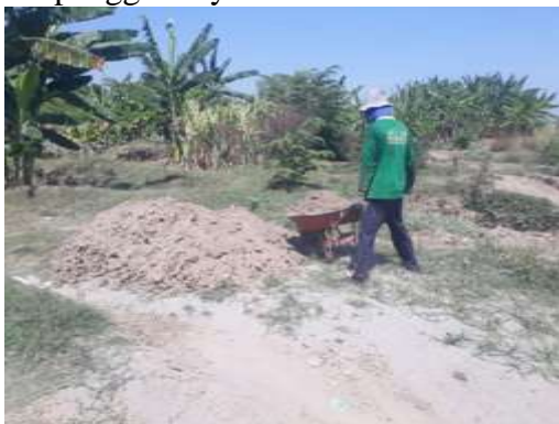
Gambar 2. Proses pengangkutan material Kendala dari alat ini yaitu membutuhkan tenaga manusia yang besar untuk dapat mengangkat material tanah liat yang lebih banyak, sehingga untuk meningkatkan kinerja kerja dari alat tersebut dan mengurangi beban manusia yang digunakan maka batu bata harus dilakukan perancang
