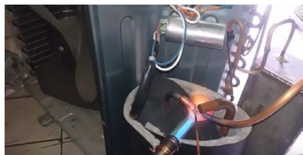
Gambar 6. Proses pengelasan sambungan
