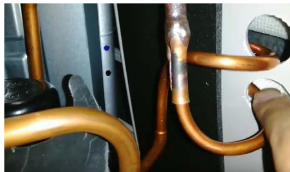
Gambar 5. Pemotongan pipa dari kompresor ke kondensor yang kemudian akan di pasang heat exchanger
